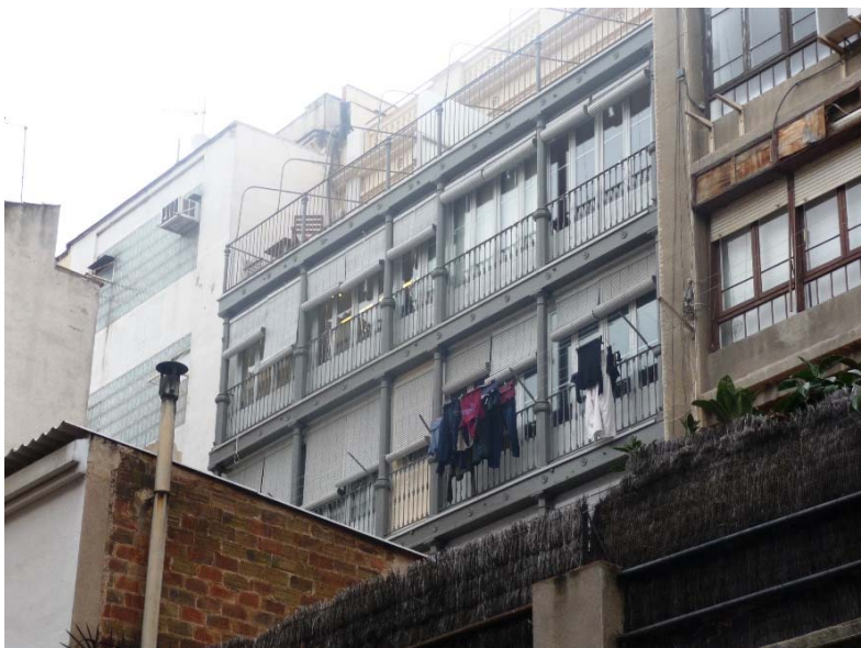
fig.143 Façana posterior que dóna al carrer Riera de Sant Miquel.
