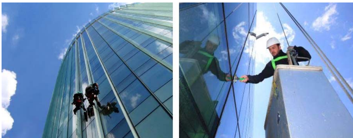
fig.140 Góndoles. Sistemes de neteja del mur cortina
