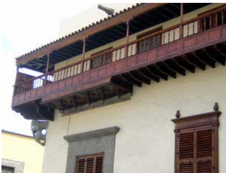
fig. 44 Balcó canari amb empit, pilars de fusta i teulada
