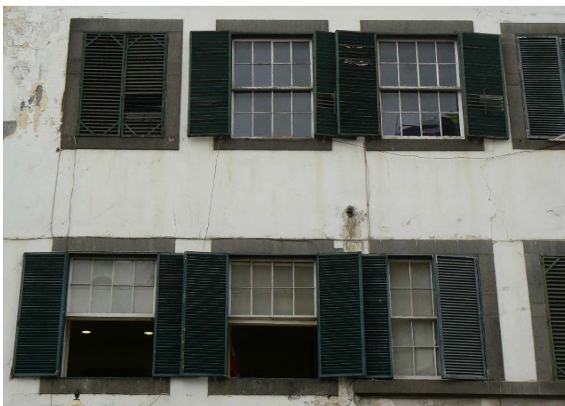
fig. 164 Finestres amb elements de control ambiental
