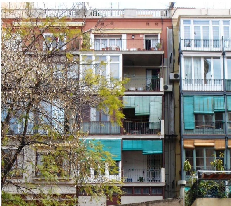
fig. 11 Galeries al pati interior d'illa. Torre de les Aigües
