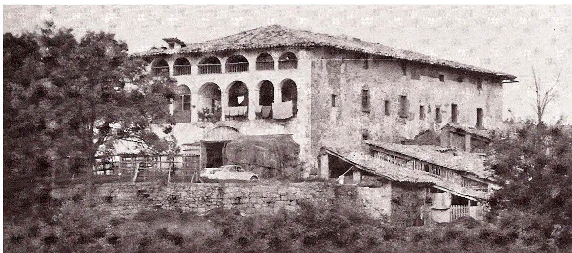
fig. 37 Masia catalana amb doble galeria d'arcs, Santa Maria de Corcó
