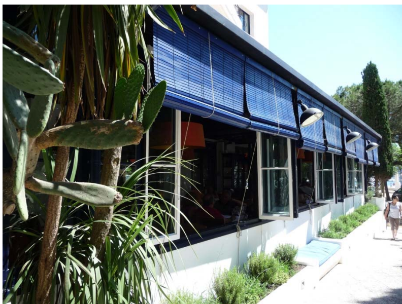
fig. 8 Sistemes de protecció solar a la façana. Hotel Trias, Palamós
