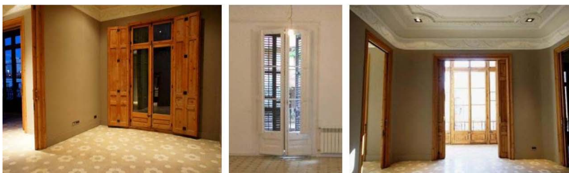
fig. 169 Tancaments interior amb contrafinestres i amb corredisses
